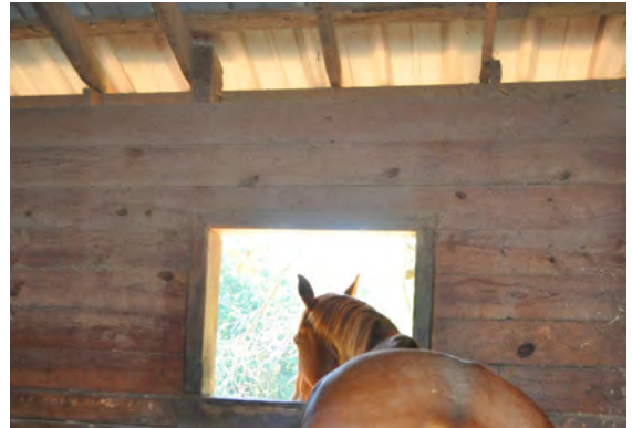
L'espace entre les parois et la toiture permet une bonne ventilation naturelle.
