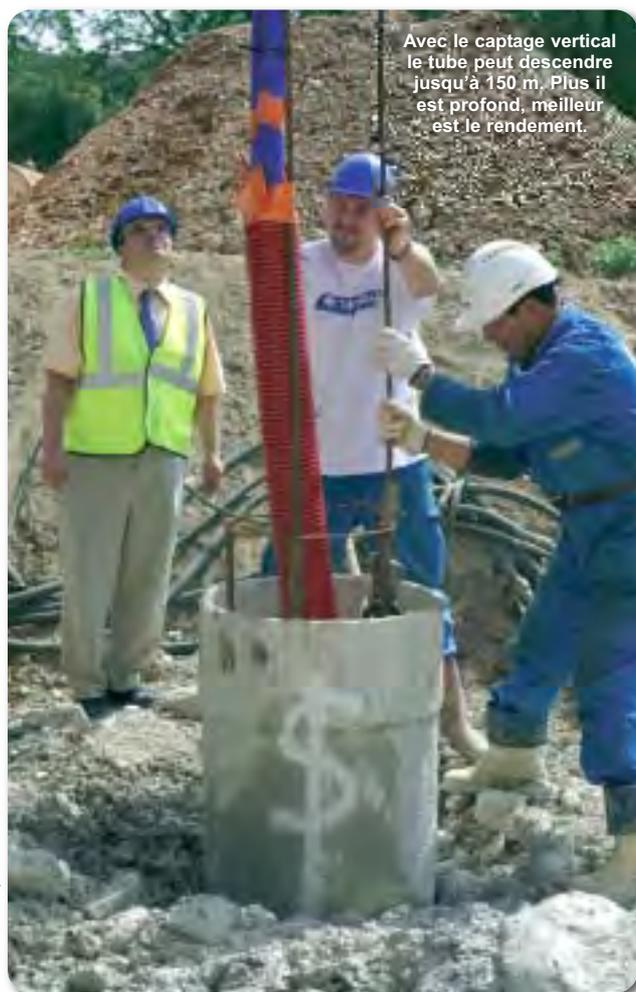
Avec le captage vertical le tube peut descendre jusqu'à 150 m. Plus il est profond, meilleur est le rendement.
