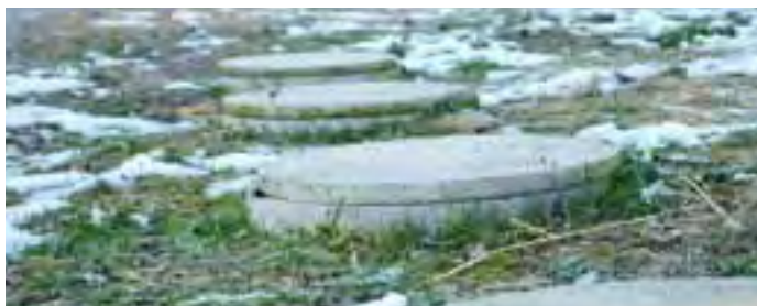
Les cuves de récupération d'eau sont reliées entre elles.
