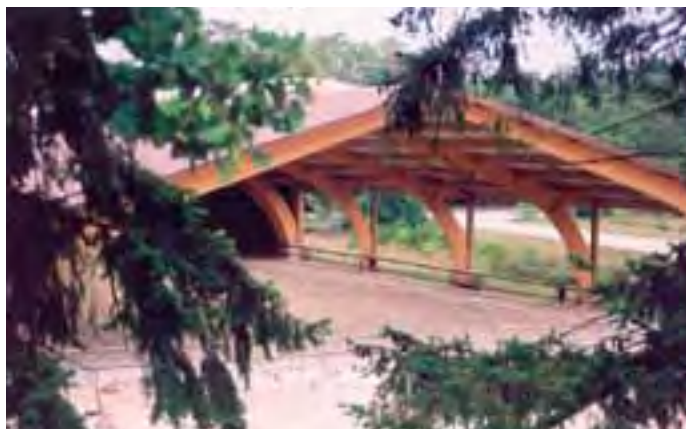
Les grandes surfaces de toiture permettent une récupération d'eau efficace
