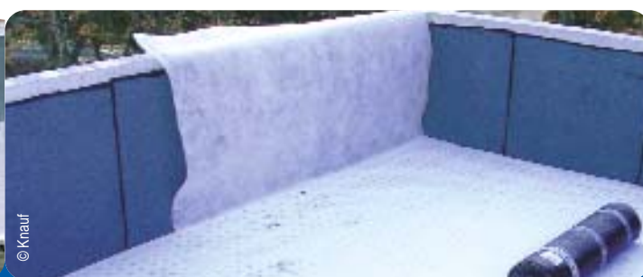
POSE DE LA COUCHE FILTRANTE
