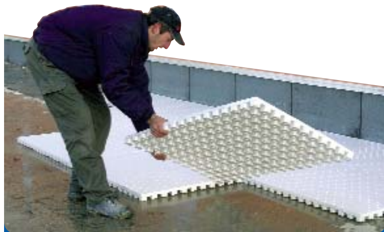
POSE DE LA COUCHE DRAINANTE
