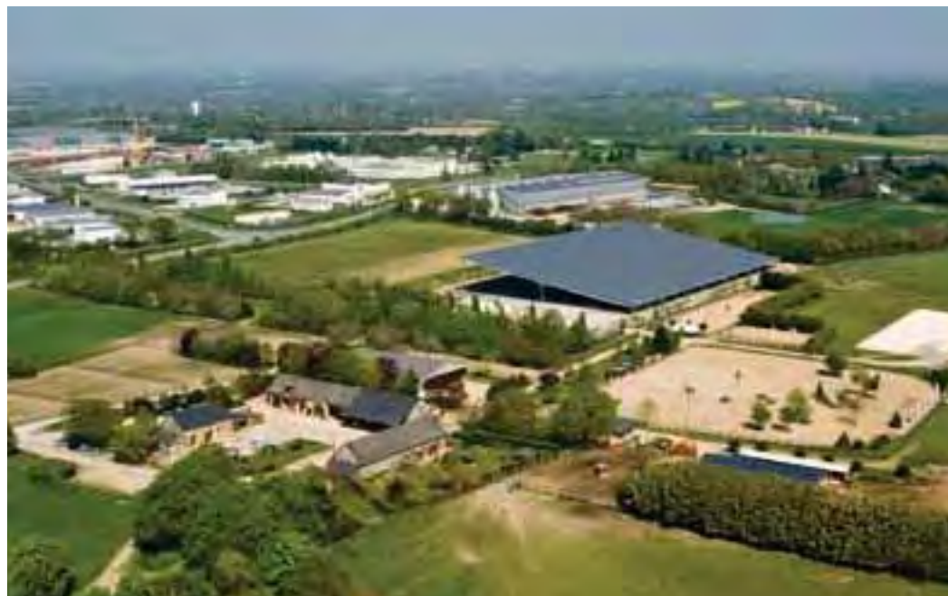
Le toit du hall équestre alimente 100 foyers en électricité
